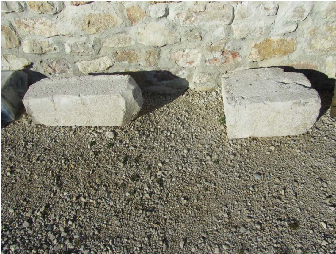
Certaines pierres servent de banc...
